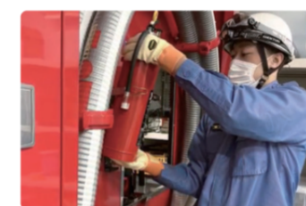
車両・資機材点検
