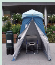
マンホールトイレ
