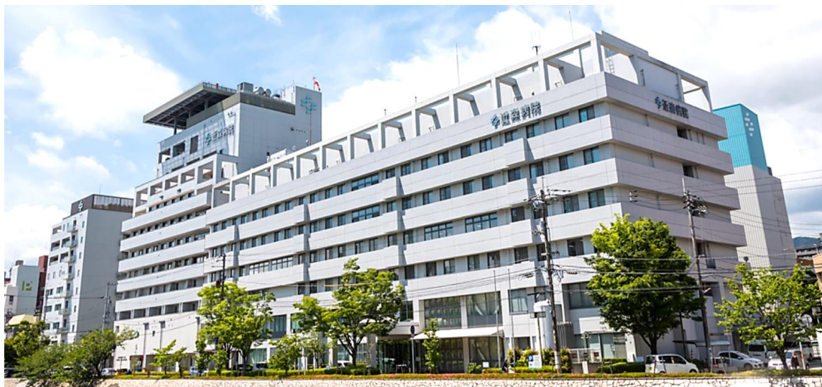
左奥の建物が外来センター。ヘリポートのある右側の建物が本館（A 棟、B 棟、C 棟） （近森病院提供）
