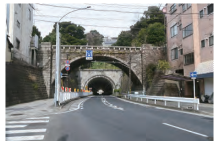
桜道橋（手前）と山手隧道（奥）
