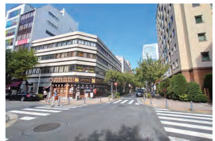
防火帯建築が建つ関内さくら通り
