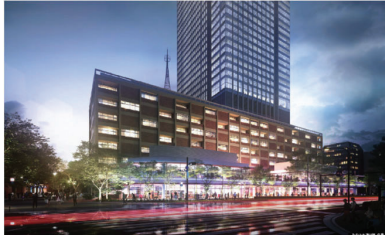
旧市庁舎街区活用事業のイメージ (イメージ図:三井不動産株ニュースリリース)
