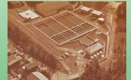
完成した鶴ヶ峰沈でん池
