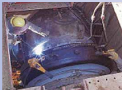
漏水防止金具設置(送配水幹線の補強)
