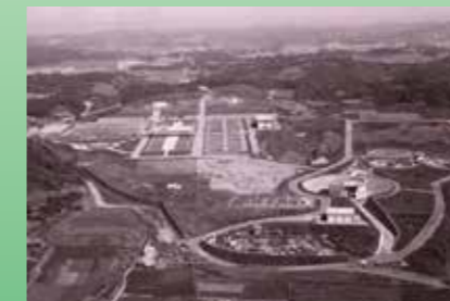
第 1 回拡張工事 完成間近の小雀浄水場
