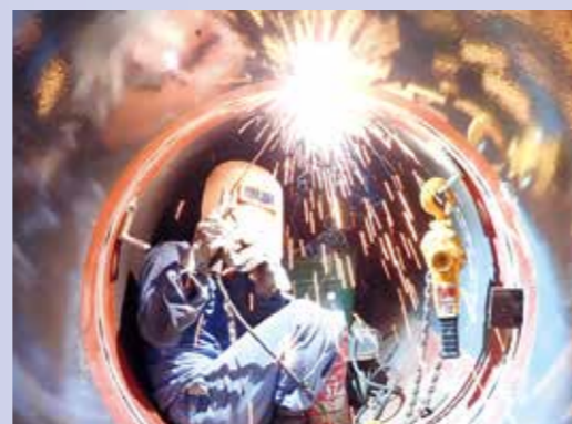
老朽管耐震更新工事(管内溶接)
