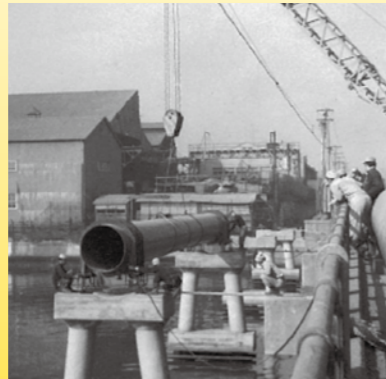
建設中の大黒水管橋
