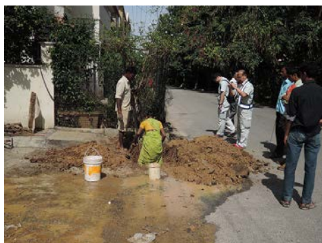
(左) 監視機器により発見された漏水箇所の補修、(右) 量水器内に設置した漏水監視装置
