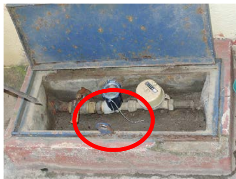
(左) 監視機器により発見された漏水箇所の補修、(右) 量水器内に設置した漏水監視装置
