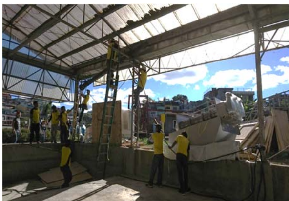
バギオ市での脱水装置据付中の様子
