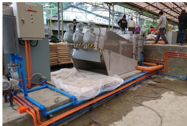
バギオ市での脱水装置据付後の様子
