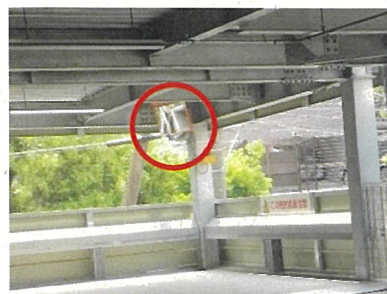
(コーナー部分への回転灯設置による注意喚起の実施)
