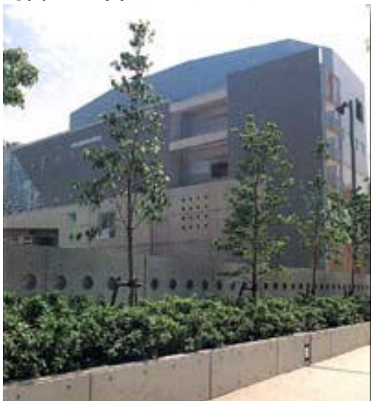
写真 6-1 西スポーツセンター
