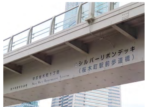
【ネーミングライツ事業】 シルバーリボンデッキ(桜木町駅前歩道橋)
