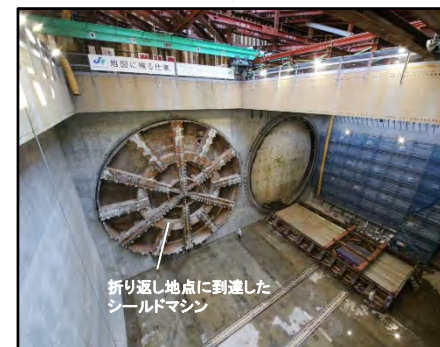
桂台トンネル工事 （栄区上郷町）
