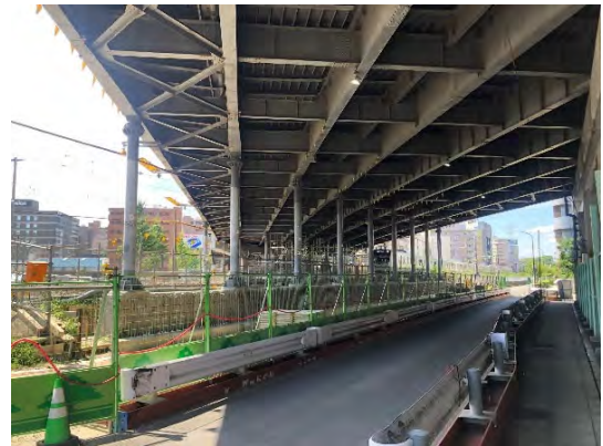
耐震補強工事:新横浜陸橋(港北区)
