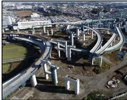
栄IC・JCT築造工事 （栄区田谷町）
