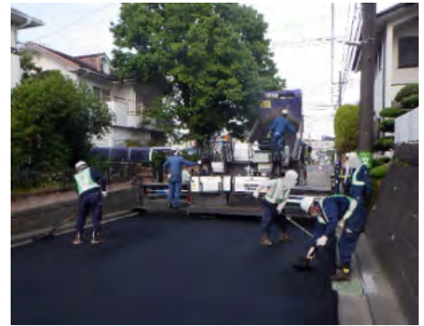
舗装修繕工事の状況(泉区)
