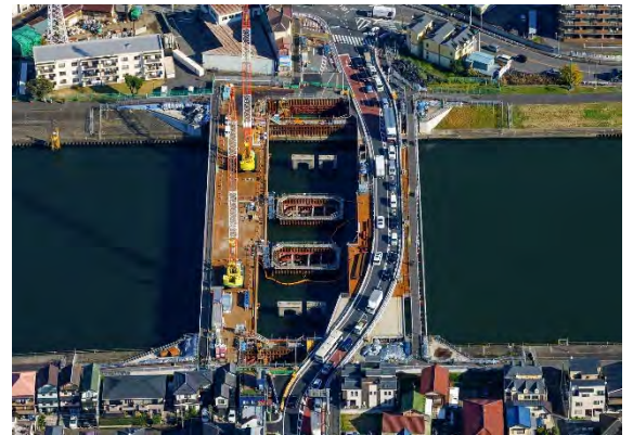
老朽橋架け替え: 末吉橋(鶴見区)
