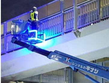
劣化状況の近接目視(夜間) 打越歩道橋(港南区)
