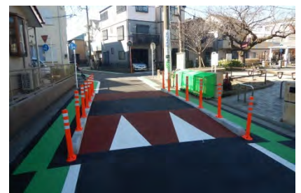
通学路の交通安全対策 (速度抑制対策: 南区大岡小学校周辺)
