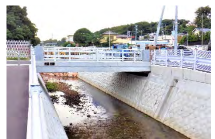
河川改修 (護岸改修・橋梁架替: 阿久和川)
