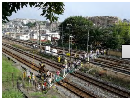
樹源寺踏切(保土ヶ谷区)現況
