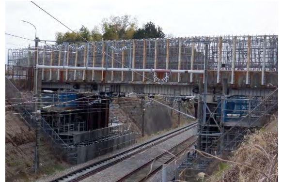
計画的な補修: 第1柳明橋(泉区)
