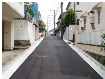
私道整備助成実施後(港北区)
