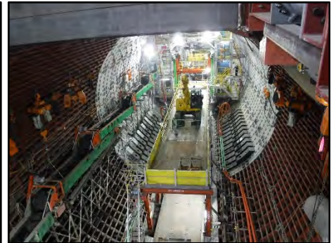
公田笠間トンネル工事 （栄区飯島町）
