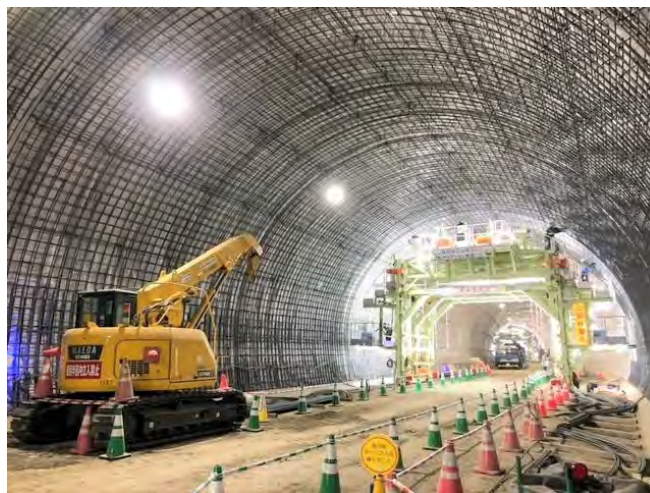
桂町トンネル工事
