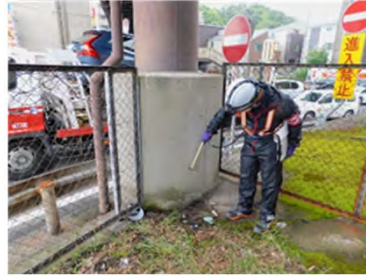
根巻コンクリート打音検査 日野歩道橋(港南区)
