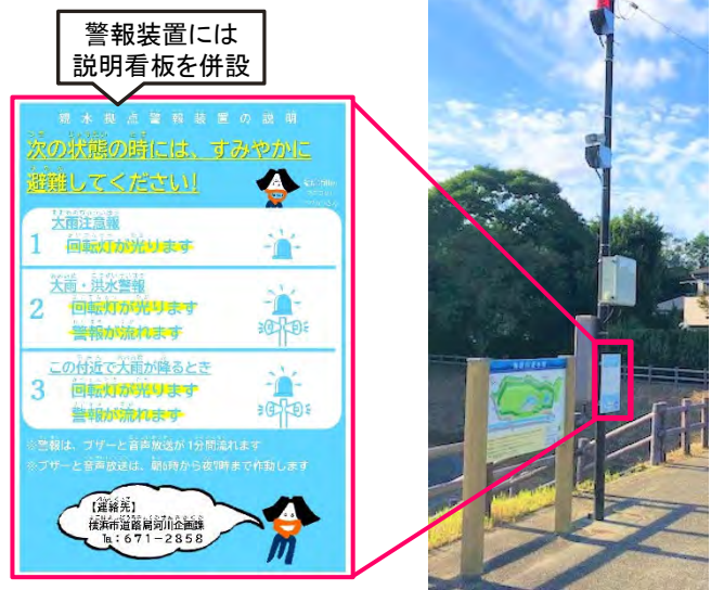
親水拠点警報装置
