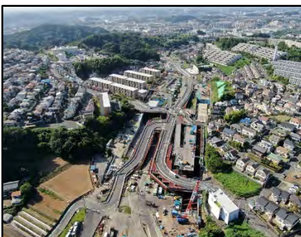
公田IC築造工事 （栄区公田町）
