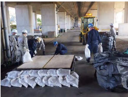
道路啓開合同訓練(段差の解消訓練) 横浜建設業協会(緑区会)・緑土木事務所
