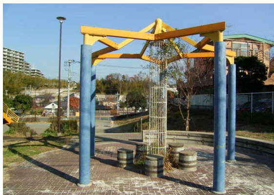
北山田ながればし公園（都筑区）パーゴラ [塗り替え前]
