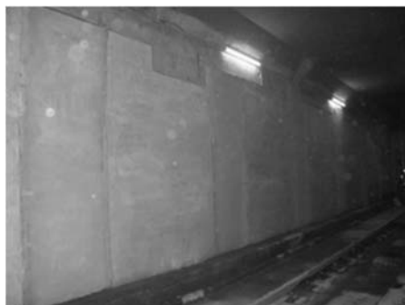
<関内駅構築補修>
