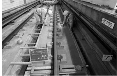
<軌道改良工事>
