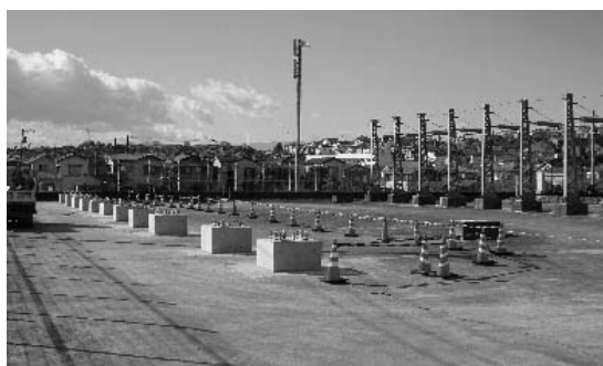
<留置線引留柱基礎工事>
