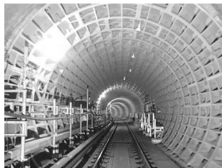
<シールドトンネルの補修>
