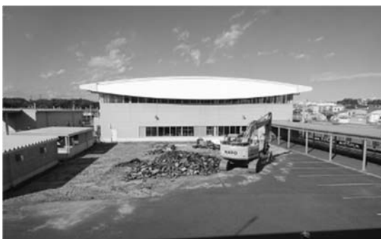
<検修庫増築工事>
