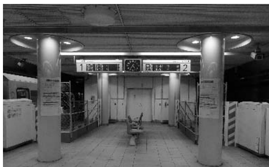
<駅ホーム工事>
