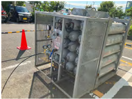
窒素ガス配管接続
