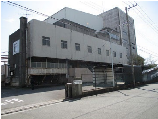
現況写真①
