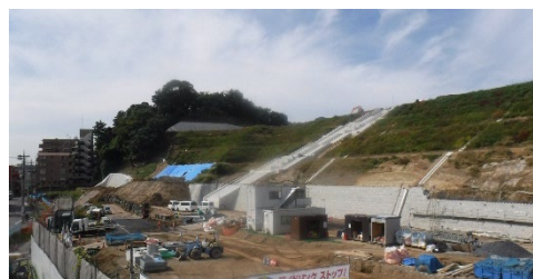
集合住宅建設用地（整備中）
