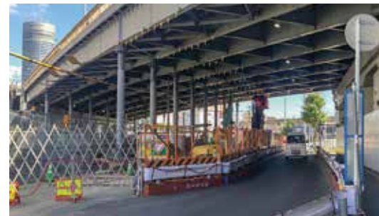
新横浜陸橋(港北区)
