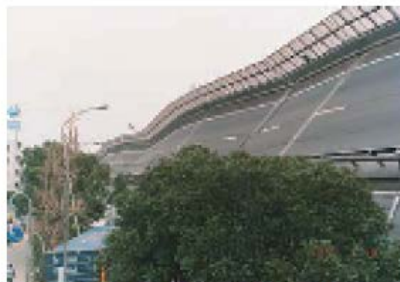
阪神高速道路の高架橋の倒壊
