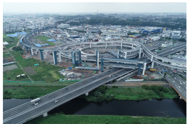
横浜環状北西線（川向地区）
