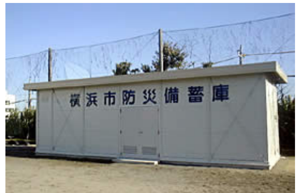
地域防災拠点の防災備蓄庫
