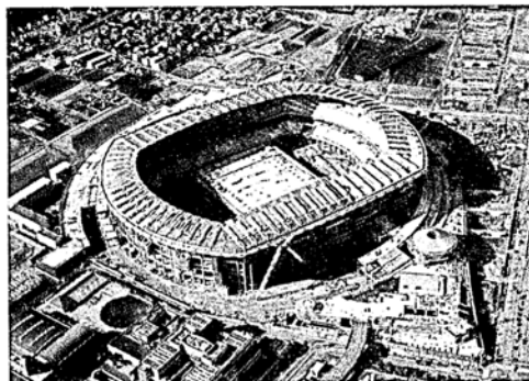
建設中の横浜国際総合競技場
