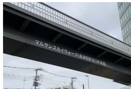
主桁への愛称標示
