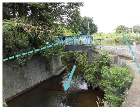
橋際橋架替え 阿久和川：泉区新橋町
