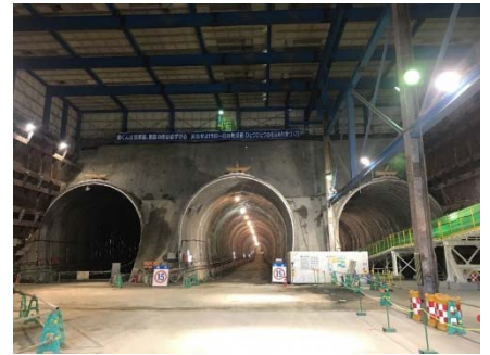
庄戸トンネル工事(栄区庄戸)
