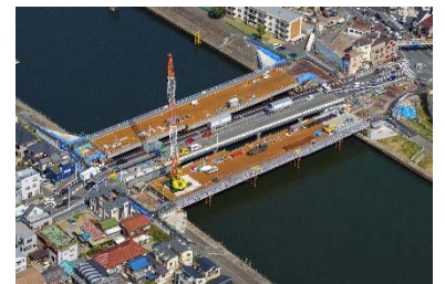
橋梁の架け替え(末吉橋)
