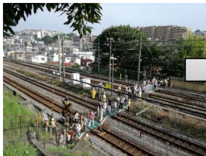
樹源寺踏切(保土ヶ谷区)現況
