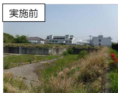
樹木伐採、除草、堆積土砂の掘削 (釜利谷南4丁目1号雨水調整池)
