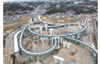
横浜環状南線・横浜湘南道路の整備 (仮称IC・JCT)
