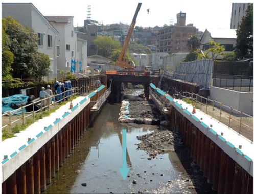
護岸改修 (今井川：保土ヶ谷区岩井町)
