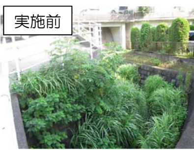
樹木伐採、除草 (侍従川支川)
