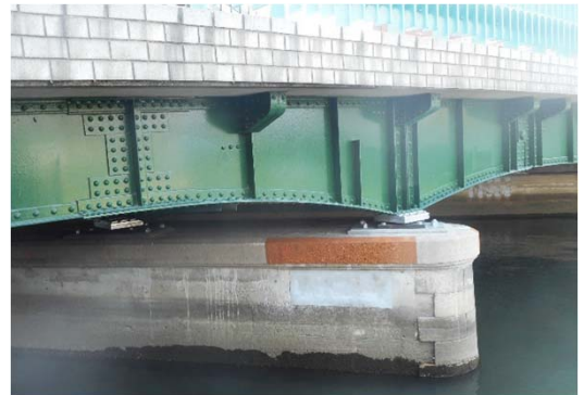
万里橋(西区): 支承取り換え、落橋防止装置
