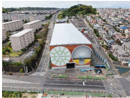
桂台トンネル工事(栄区上郷町)
