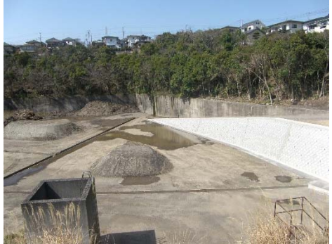
既設雨水調整池改良 (本郷台第一雨水調整池：泉区本郷台五丁目)
