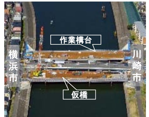
老朽橋架替え: 末吉橋(鶴見区) (令和3年3月時点の現場状況)
