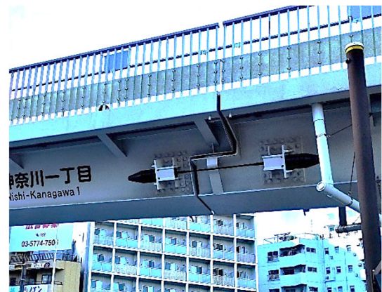
東神奈川駅前第一歩道橋(神奈川区): 落橋防止装置 令和4年11月完成
