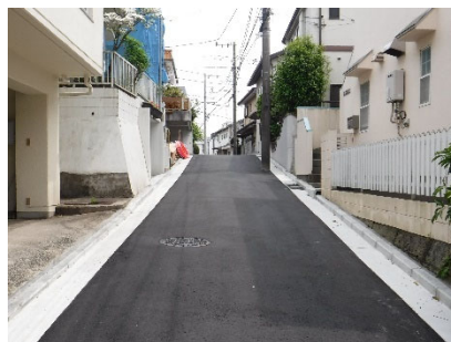
私道整備助成実施後(港北区)
