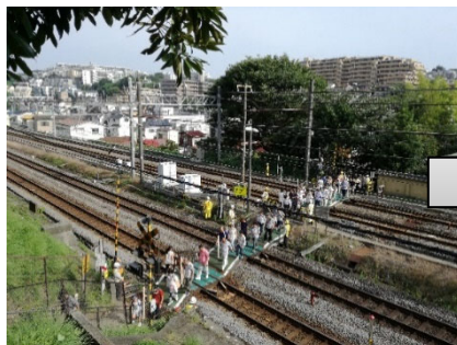
樹源寺踏切(保土ヶ谷区)現況
