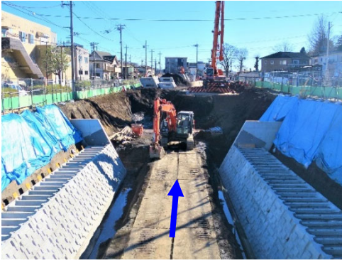
護岸改修、橋梁新設、護岸設計 (帷子川：旭区川井本町)
