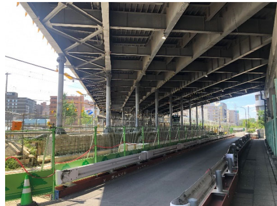
耐震補強工事:新横浜陸橋(港北区)
