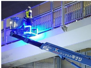
劣化状況の近接目視(夜間) 打越歩道橋(港南区)
