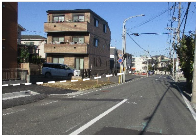
歩道整備 市道上大岡第149号線・第168号線(南区大岡五丁目)
