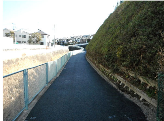
岩川沿いルートの舗装新設
