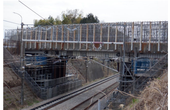
計画的な補修: 第1柳明橋(泉区)
