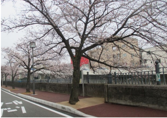
大岡川プロムナードの舗装改修
