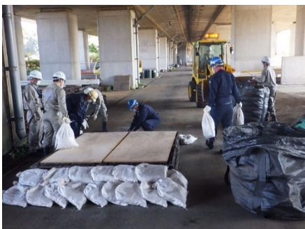
道路啓開合同訓練(段差の解消訓練) 横浜建設業協会(緑区会)・緑土木事務所
