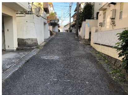
私道整備助成実施前(港北区)
