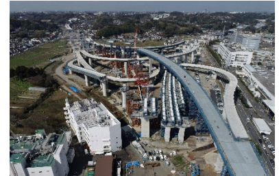
横浜環状南線・横浜湘南道路 (高架橋整備:栄IC・JCT)
