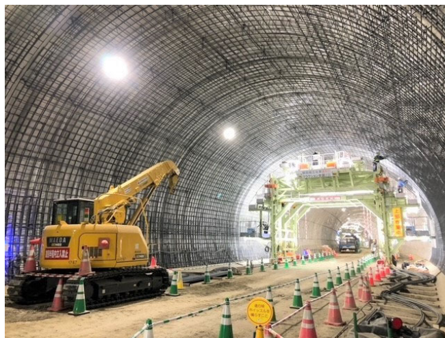
桂町トンネル工事
