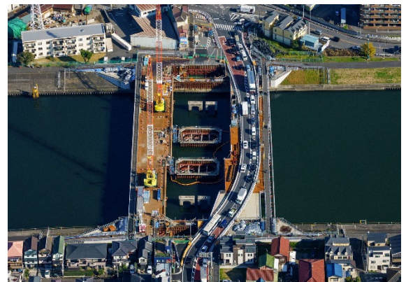
老朽橋架け替え: 末吉橋(鶴見区)
