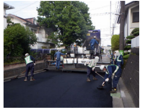
舗装修繕工事の状況(泉区)
