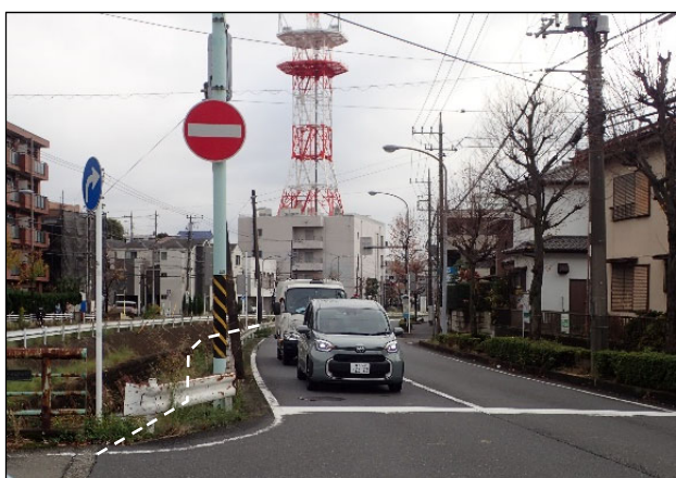
交差点改良・右折レーン設置 県道横浜生田(青葉区元石川町)【平原橋交差点】
