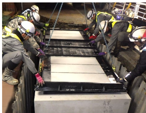
特殊部設置状況
