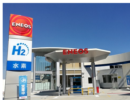
横浜綱島水素ステーション
