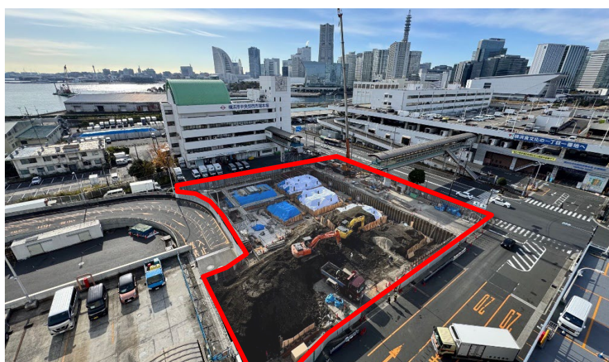
F1棟工事の様子(6年12月撮影)
