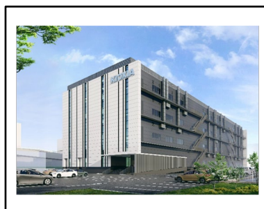
キオクシア株式会社 新子安テクノロジーフロント(神奈川区)
