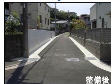
狭あい道路拡幅整備工事
