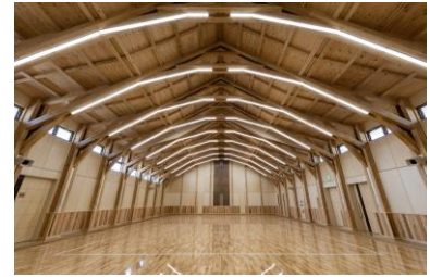
木造で整備した新井中学校武道場
