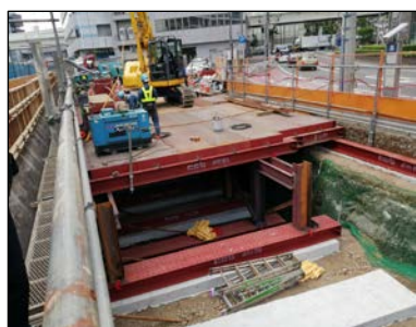
【護岸復旧工事】
