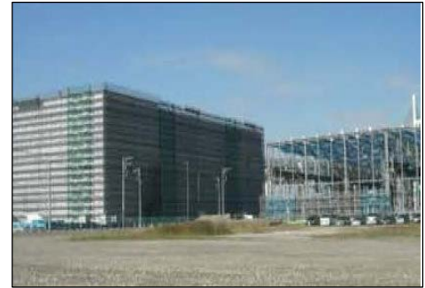
【本牧ふ頭A突堤 建設中のロジスティクス拠点】
