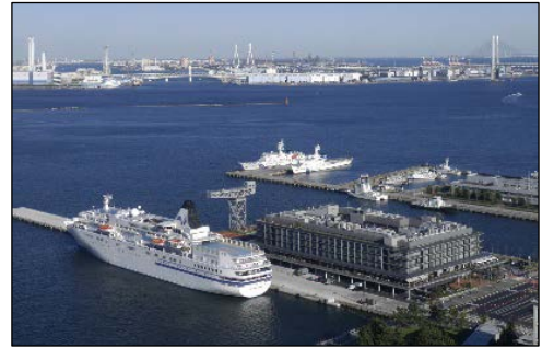
【新港ふ頭客船ターミナル】
