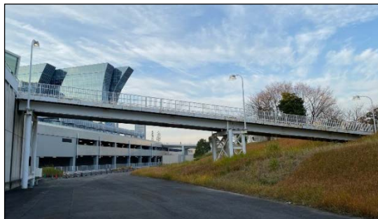
【現在の仮設デッキ】
