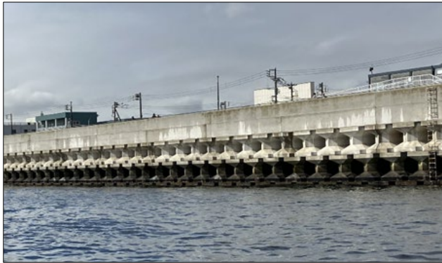
【金沢区福浦地区護岸復旧状況】
