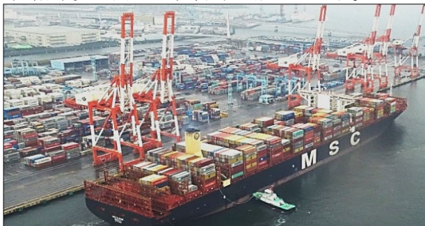
【南本牧ふ頭に着岸する世界最大級の超大型コンテナ船】
