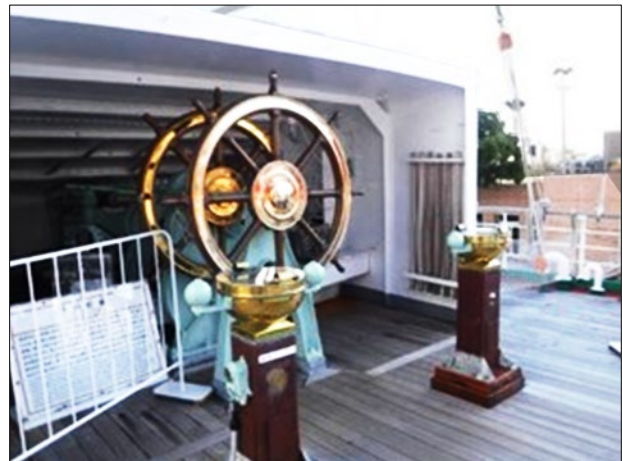
【補修が必要な手動操舵装置周辺】
