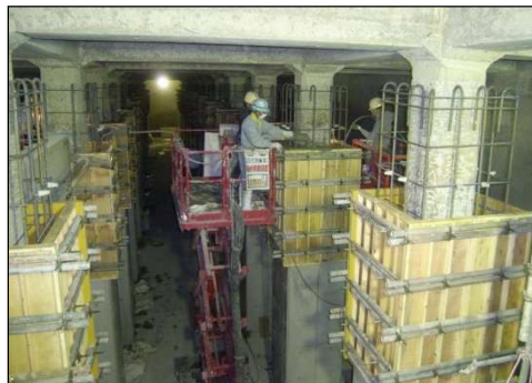
配水池の耐震補強工事
