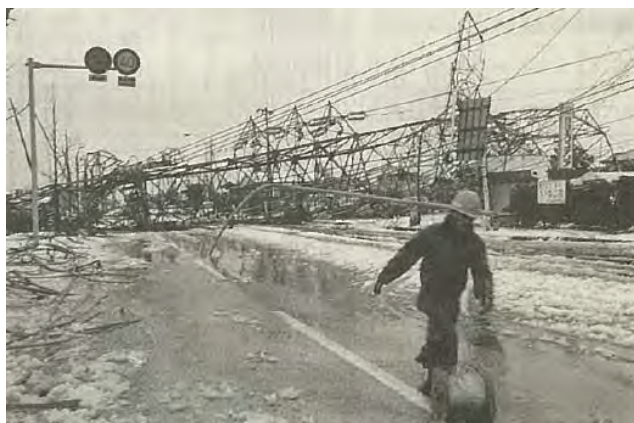
大雪による送電鉄塔の倒壊 (昭和 61 年)
