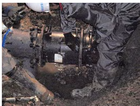
配水管の布設替工事
