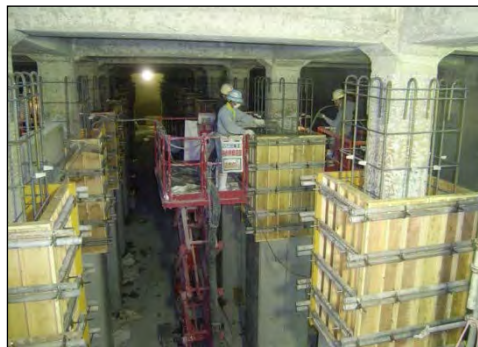
配水池の耐震補強工事
