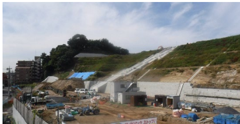
集合住宅建設用地（整備中）
