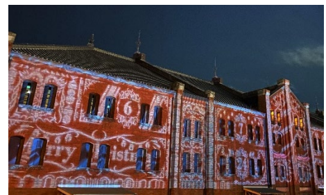
イベント時の屋外広告物に関する協議制度活用例 （赤レンガ倉庫のプロジェクションマッピング）
