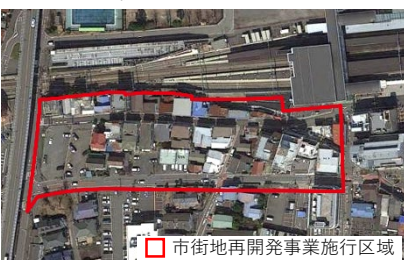
施行前の状況
