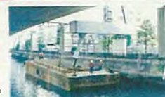
図2 横浜市工事での実績
