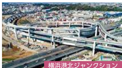
横浜港北ジャンクション
