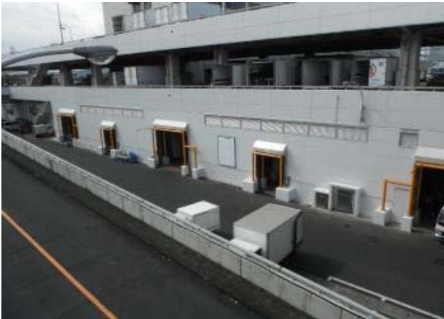
①外壁改修
