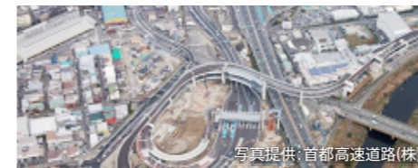
写真提供：首都高速道路(株) 横浜港北ジャンクション
