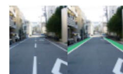
施工前 施工後 あんしんカラーベルト
