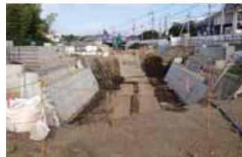
帷子川における河川改修(旭区)
