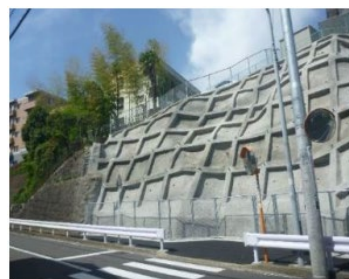
<道路がけ防災対策後>
