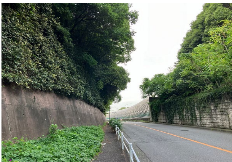
常盤台和田町線沿いの樹木（峰岡町 3 丁目付近）
