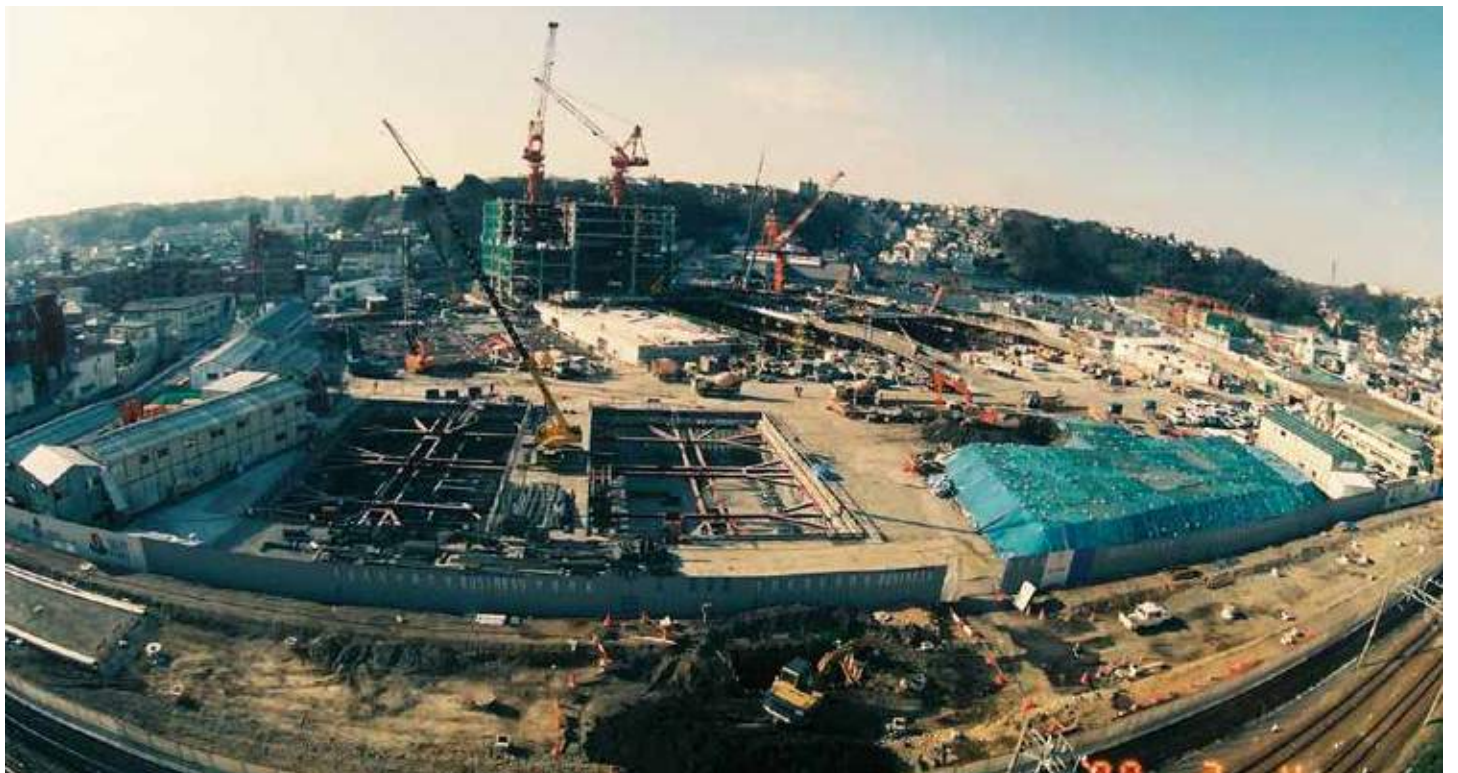
建設中の横浜ビジネスパーク
