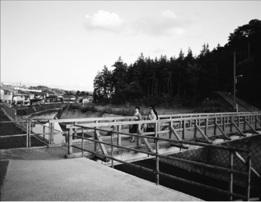
帷子川に架かる木橋の学校橋
