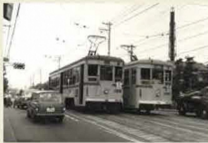
韋名橋 提供:横浜市電保存館
