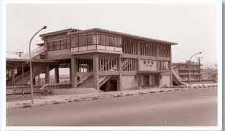
昭和39年 建設中の磯子駅の様子
