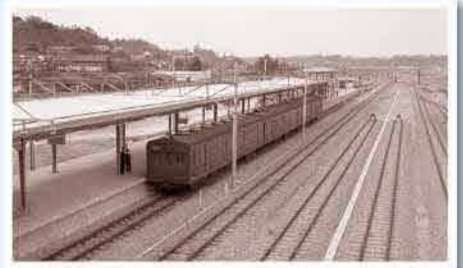
昭和39年 開業前の磯子駅 ホームの様子
