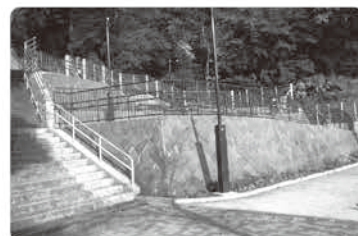
津波避難施設
