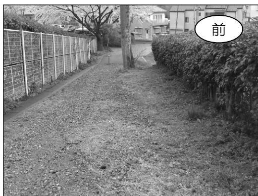
【事例】 路面舗装
