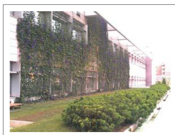
建築物の外壁面の緑化
