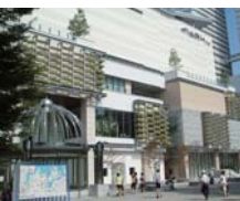
商業施設の壁面緑化の様子(西区)
