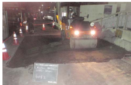
写真① 舗装復旧工事
