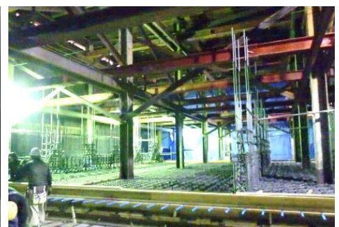
写真② 鉄筋の組立
