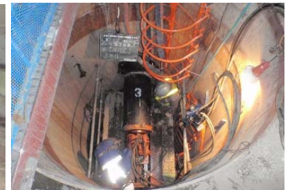
写真② 立坑内部
