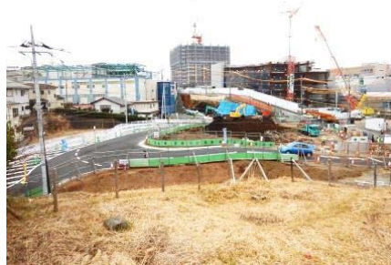
写真① 切り回し後の生活道路
