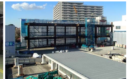
写真② 駅舎増築部鉄骨工事
