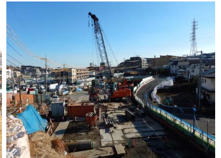
写真② 基礎杭の工事
