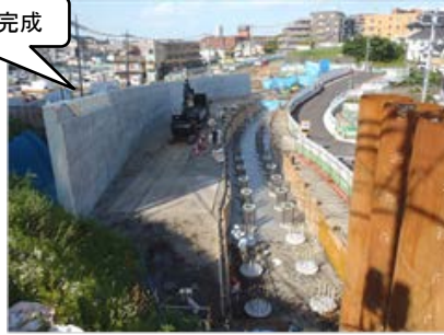
写真① L型擁壁工事
