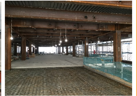
写真② 増築部内装工事
