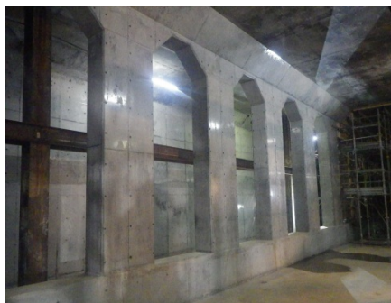
写真① 本体構造物
