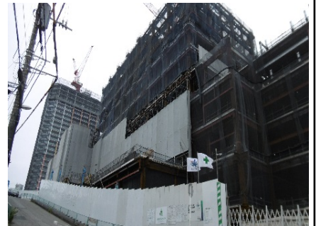
写真② 商業・業務棟(南面)
