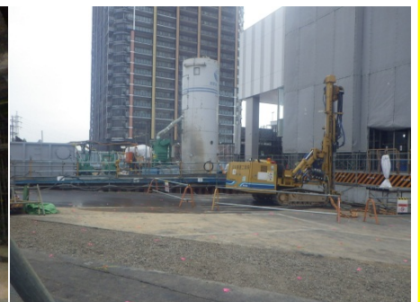
写真② 地盤改良工事
