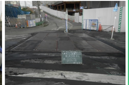
写真② 覆工板設置状況
