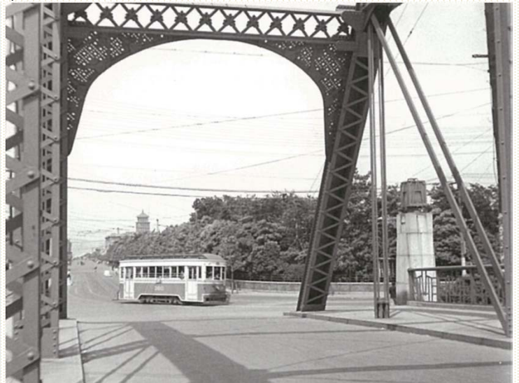
1939年（昭和14）頃。港橋から横浜公園方面をみている。橋門構（写真上部）の鋼材部が残されている
