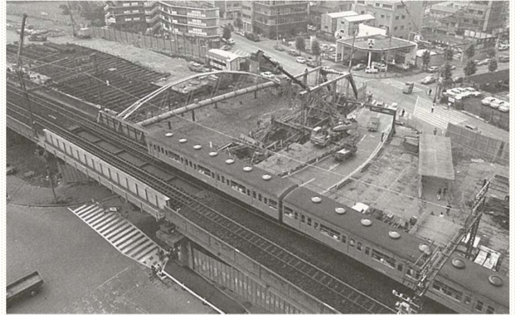
取り壊される港橋（1973年（昭和48）6月）
