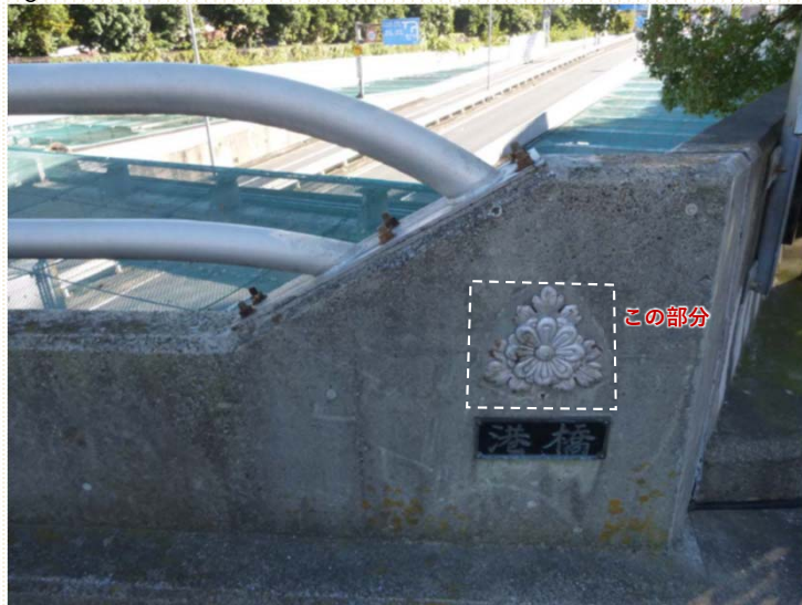
港橋の高欄（現在）、「港橋」と書かれた橋名板と花の紋章が取り付けられている
