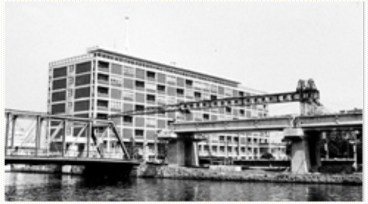
1961年（昭和36）8月頃。JR関内駅は建設中。左手が港橋
