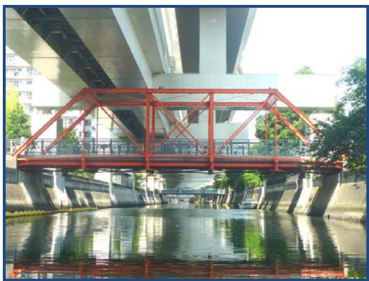
浦舟水道橋(南区)
