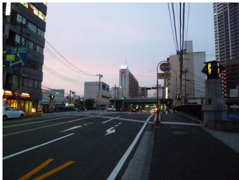
浅山橋全景 (灯具設置後)
