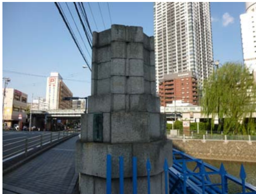
施工前 (灯具設置前)
