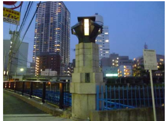
施工後 (灯具設置後)
