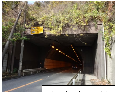
坑口部(金沢区側)
